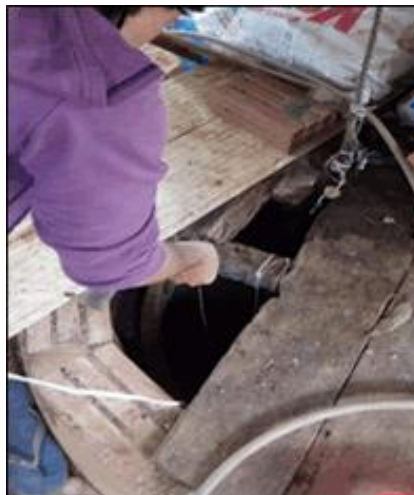
B) Poço com tampa improvisada com madeira e forro PVC (Policloreto de polivinila) em ambiente coberto, mas com presença de sujeiras na superfície.
