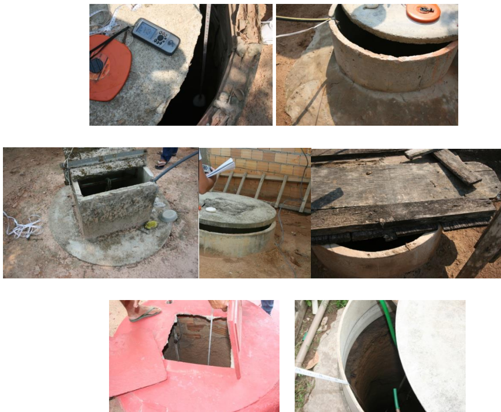
Figura 2. Tamponamento dos poços do entorno do lixão desativado, Ji-Paraná.
