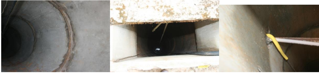
Figura 3. Detalhe do revestimento das paredes em três poços analisados.
