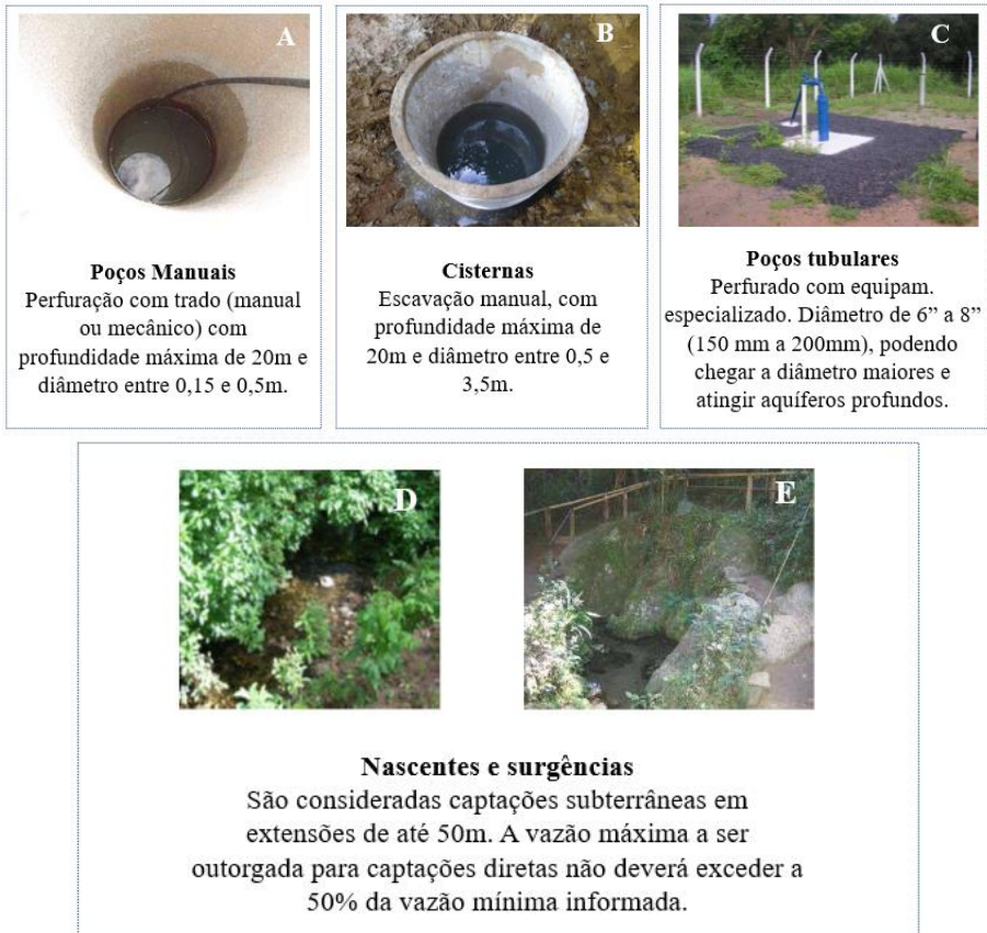
Figura 1 – Exemplos de exploração de água subterrânea. Em (A) Poços Manuais, (B) Cisternas, (C) Poços tubulares, (D e E) Nascentes e surgências.
