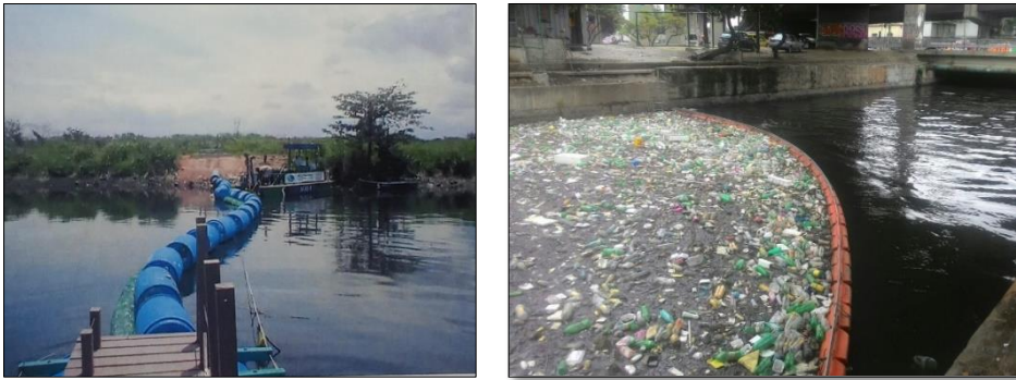
Figura 1. A – Estrutura de bombona de plástico (de 2009 a 2015); B – Estrutura de grade de aço (de 2015 até atualmente).
